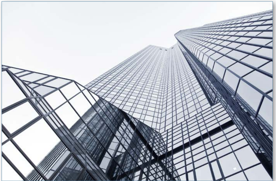
Centrála spoločnosti VARIANT-HAUS-GROUP, Frankfurt am Main
